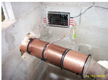
**FIGURA 09:** Equipo antical VULCAN instalado en una impulsión.
